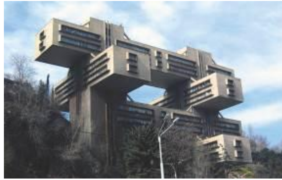
شكل ( ٢ ) التناقض في طبوغرافية الموقع، مكاتب مهندسو الطرق بتبليسي (١)
