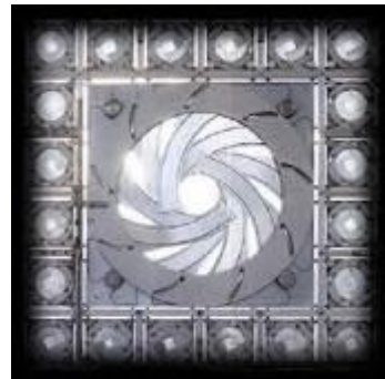
شكل رقم (١٠) يوضح اتساع حركة المشربية عند الحاجة لضوء الشمس، وإغلاق فتحاتها عند زيادة كمية الضوء
